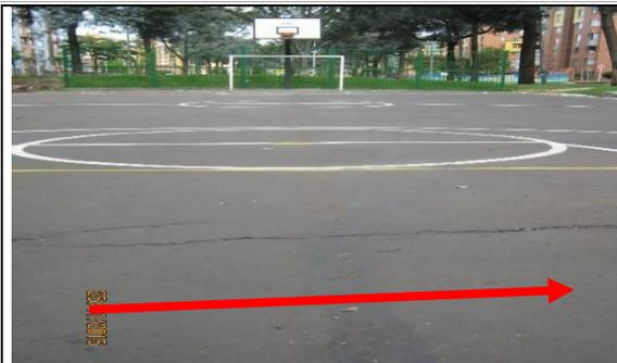
**Foto 3.** Según registro fotográfico en la construcción y colocación del pavimento flexible se encuentran grietas transversales.
