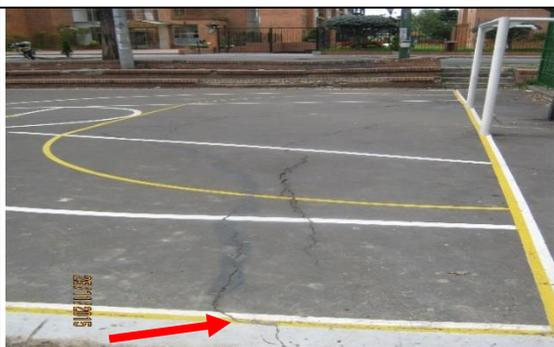
**Foto 6.** Según registro fotográfico en las grietas transversales se observa parches con un material que difiere del tipo de pavimento flexible que fue aplicado.
