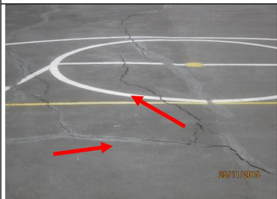
**Foto 7.** Se observa la forma de desintegración de la superficie, posiblemente por calidad deficiente de algunas de las capas de la sección estructural. El gran avance y deterioro de la superficie pavimento flexible (asfalto R-1350).
