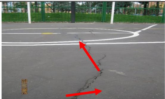
**Foto 4.** Se observa grieta, siguiendo un patrón longitudinal.
