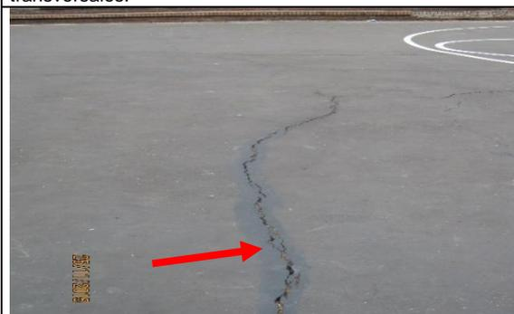
**Foto 5.** Según registro fotográfico en las grietas transversales se observa un material extraño que difiere del tipo de pavimento flexible que fue aplicado.
