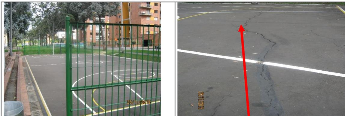
**Foto 1: panorámica del parque.** En la imagen se observa el área total de la cancha de básquetbol que fue intervenida. (Carpeta de rodadura asfáltica MDC-3 de 5.5 cm de espesor).
